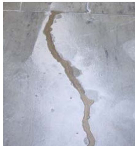
May Werke GmbH & Co. KG, Erfstadt-Köttingen: Renovation of expansion joints
