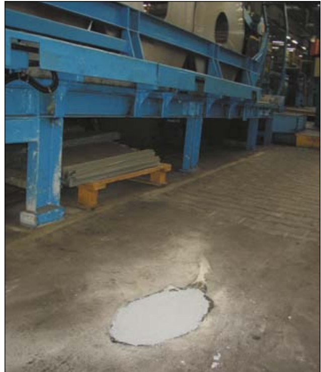
Top: MHP Mannesmann Präzisionsrohr GmbH, Hamm: Repairing pot holes
